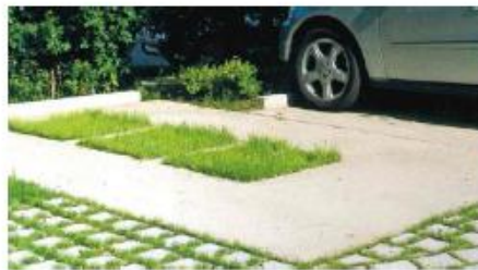
Béton avec espace engazonné central
