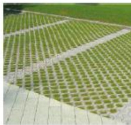
Dalles béton alvéolées engazonnées
