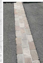
marquage résine sur enrobé
