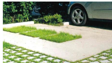
Béton avec espace drainant engazonné
