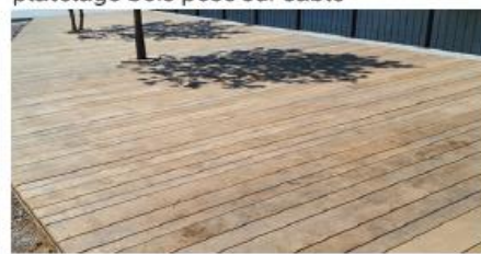
platelage bois posé sur sable
