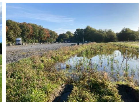
La noue derrière le parking PL
