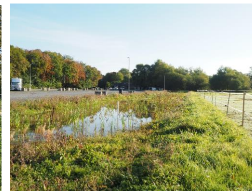
Vue de la noue le long du parking
