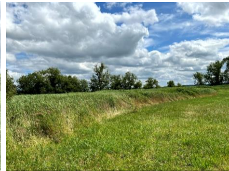
Zone du platelage
