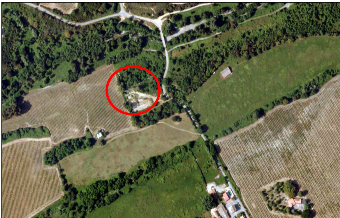
La station d'épuration d'Aghione
