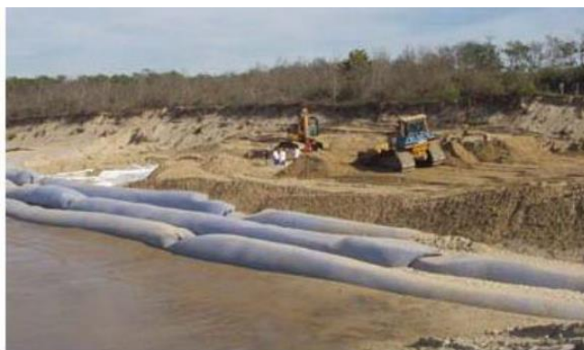
FIGURE 2 PROTECTION PAR TUBES GEOTEXTILES EN 2002
