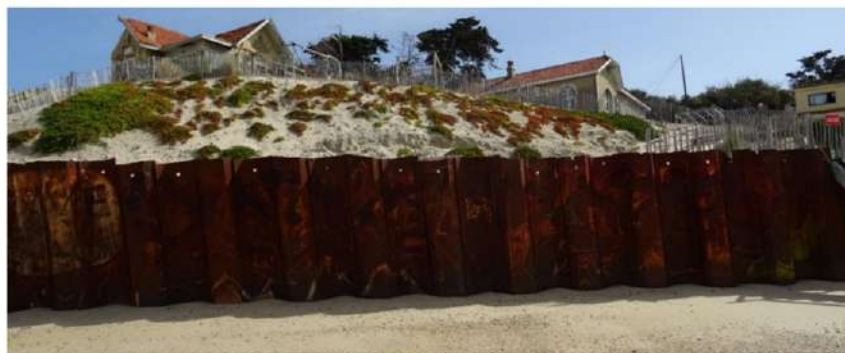
FIGURE 13. PHOTOGRAPHIE DE L'OUVRAGE (PROTECTION INDIVIDUELLE) PAR CASAGEC INGENIERIE, 12/09/22
