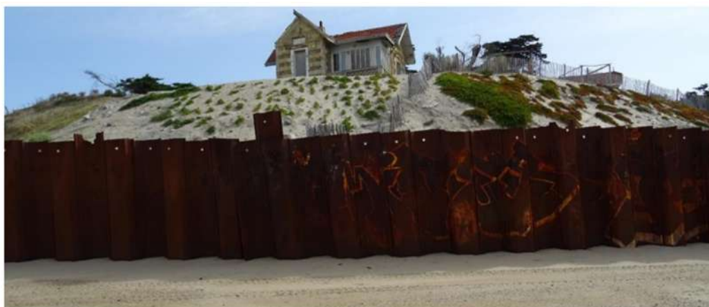
FIGURE 6. EXEMPLE DE PARCELLE PRIVEE PROTEGEE PAR DES PALPLANCHES (PROTECTION INDIVIDUELLE, CASAGEC INGENIERIE, DECEMBRE 2022)
