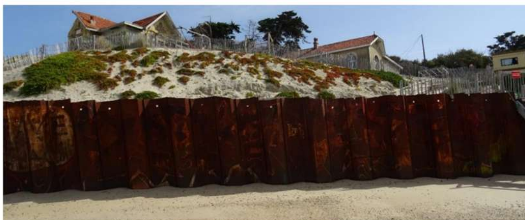
FIGURE 7. PHOTOGRAPHIES DE L'OUVRAGE (PROTECTION INDIVIDUELLE) PAR CASAGEC INGENIERIE, 12/09/22
