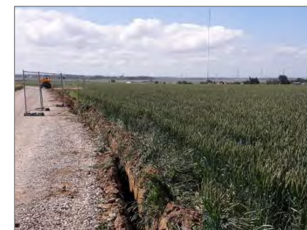
Figure 33 : Illustrations photographiques des tranchées pour le raccordement
