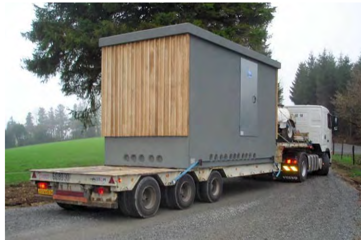
Figure 34.: Exemple de la livraison sur site d'un poste de livraison
