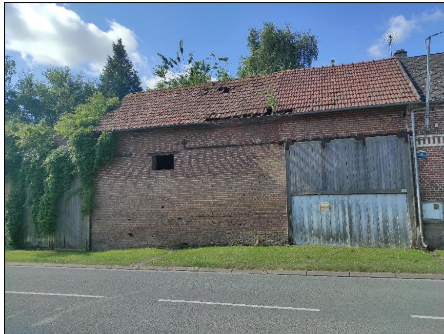
Photographie 23 : Bâtiment type grange favorable à la présence de chiroptères en gîtes
