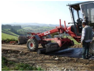
Illustration 21 : Pose du géotextile
