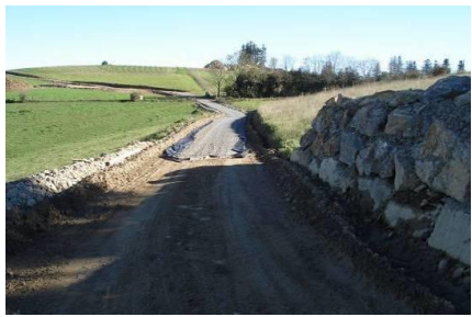
Illustration 22 : Mise en place du gravier
