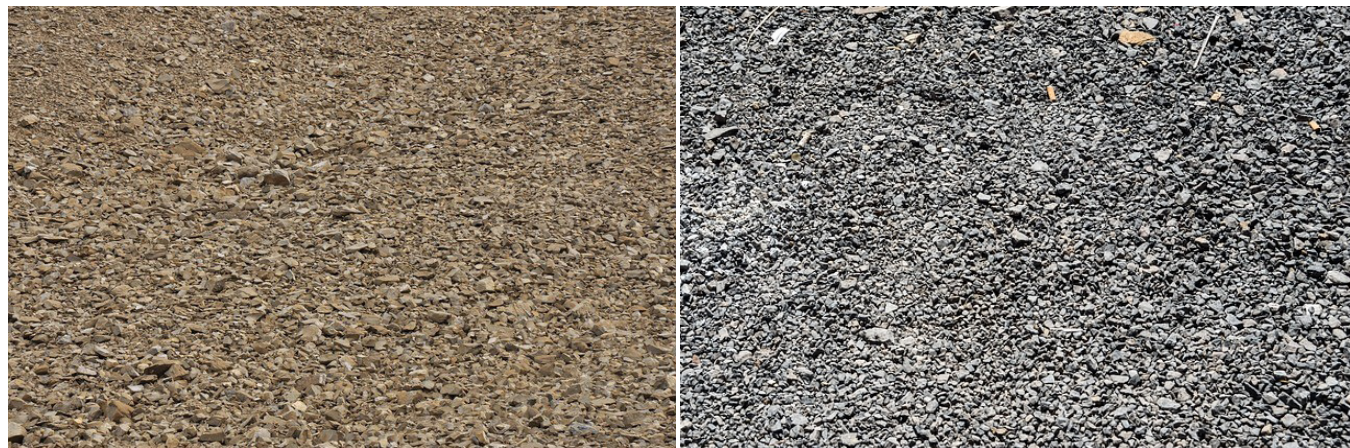
Photographie 144 : Texture des pistes en concassé calcaire / granit.
