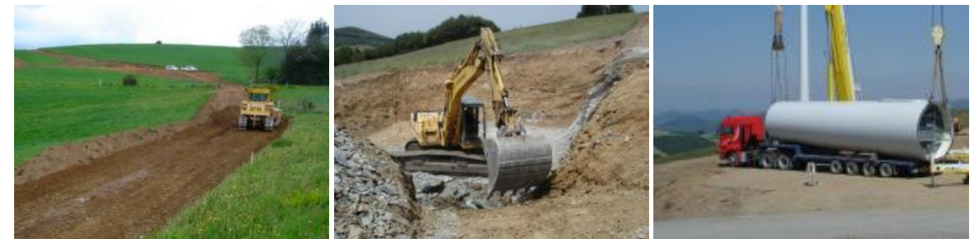
Photographie 145 : Illustration d'un chantier éolien.
