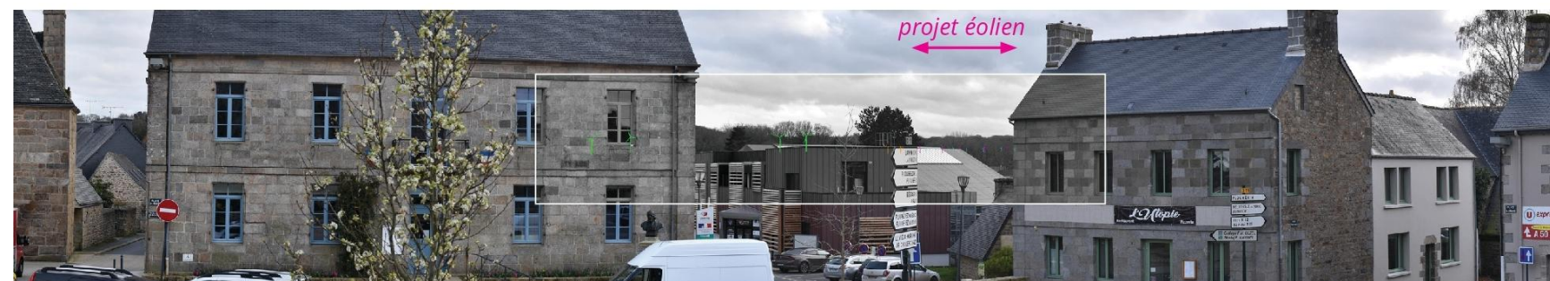
Photo 4 : Éoliennes du projet de Roc'h Glaz masquées par le relief et la végétation, depuis la place de l'église de Plouaret (Source : Encis Environnement)
