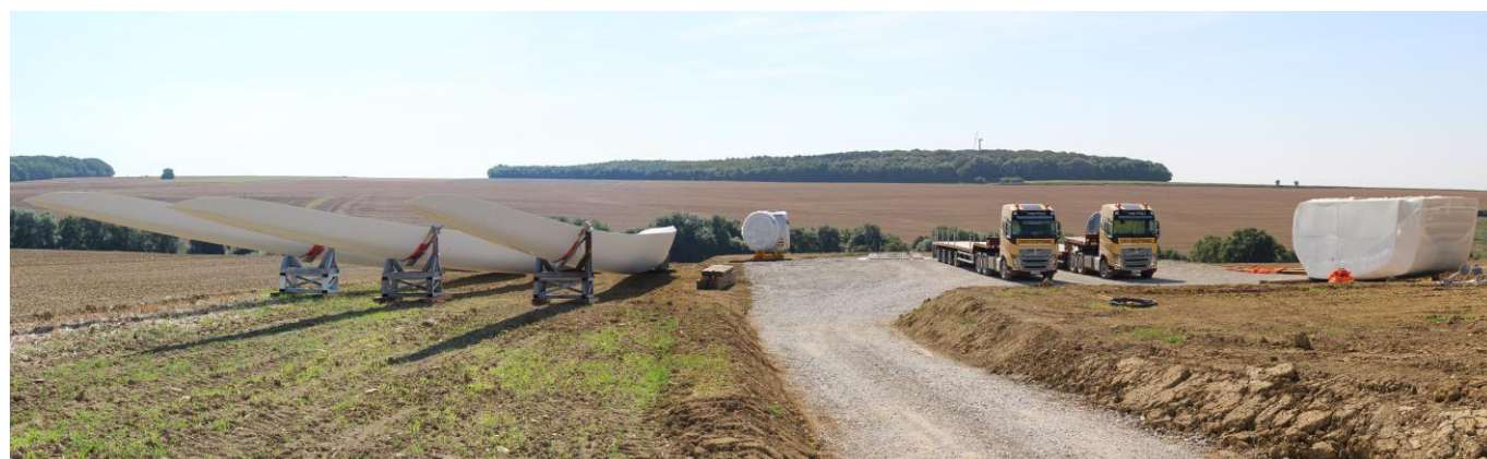
Eléments d'éoliennes avant montage (Source : Ora environnement)
