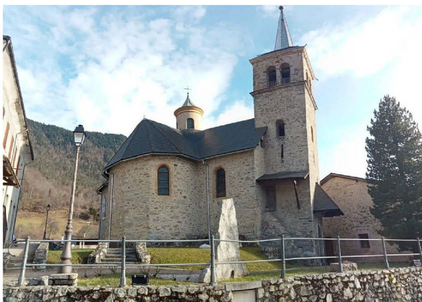
Église Saint-Martin, vue depuis l'Ouest, en bordure de route. Source: UDAP 73
