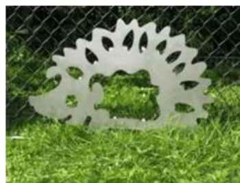
Exemple de passage petite faune au pied d'une clôture grillagée
