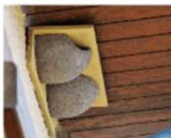
Nichoires posés sous toiture
