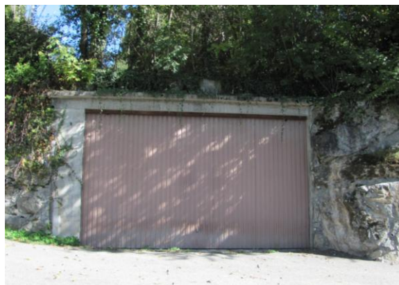
Photo 14 : Garage sur la partie sud du terrain (aval)
