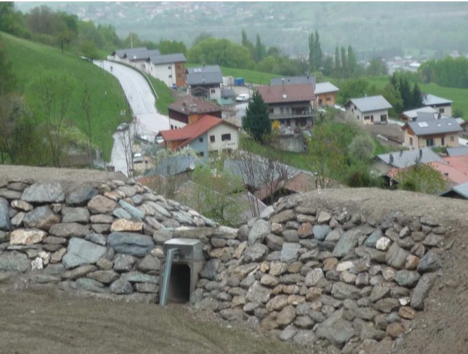
Plage inférieure avec déversoir et busage des écoulements
