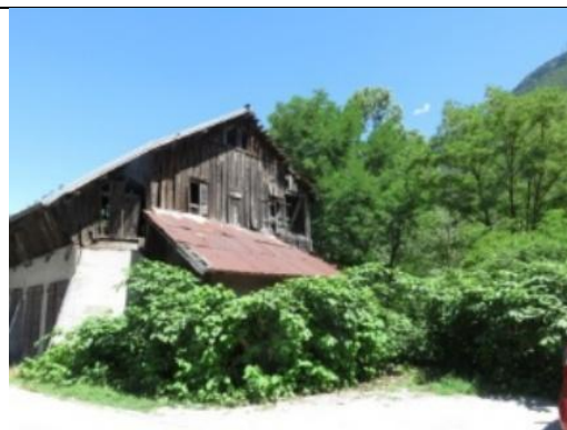
Bosquets de renouées sur le côté du bâtiment à démolir
