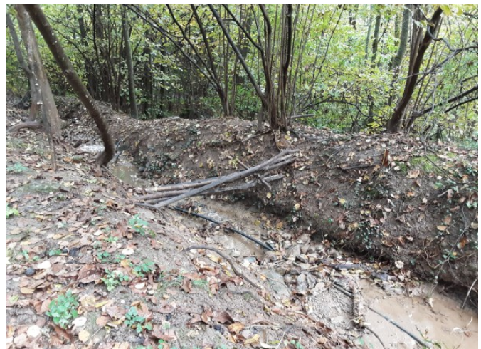
Figure III.21: Eaux de ruissellements concentrées et chenalisées traversant la combe de Villoudry à Villarbéringer.
