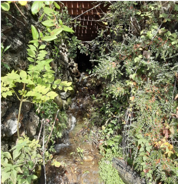
Figure III.12: ruisseau de Navette, passage couvert sous une terrasse, amont du chemin de l'Oratoire.
