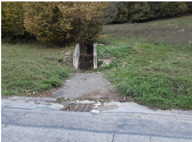
Figure III.20: Route de Villarbéringer, grille d'avaloir en aval de la combe de Villoudry à Villarbéringer.
