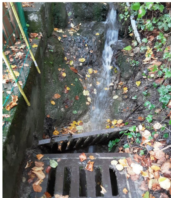
Figure III.18: Entrée du ruisseau de Grand-Cœur sous la route de Bringer par une grille de busage
