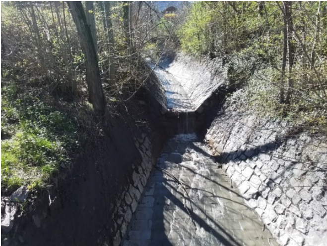
Figure III.4: Chenal en pierres maçonnées (berge et radier) sur le Nant-Noir aval. Vue depuis la RD95 aval.
