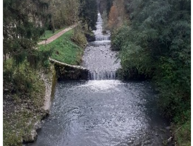
Figure III.5: Vue du Morel et de la succession des seuils en pierres maçonnées en amont de la route de Bellecombe.
