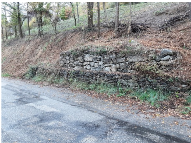
Figure III.26: Gabions anciens rue de Plansoire, à Villarbéringer.
