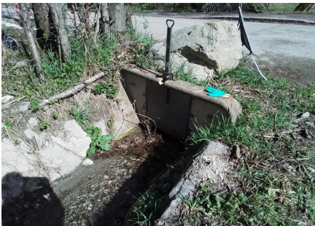
Figure III.6: Ruisseau de Saint-Laurent, vue amont du franchissement de la RD94.
