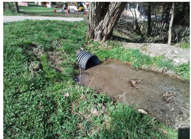
Figure III.7: Ruisseau de Saint-Laurent, vue aval du franchissement de la RD94.
