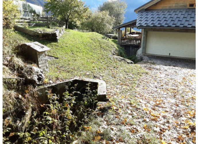
Figure III.11: Ruisseau de Navette, vue amont du passage sous l'habitation.
