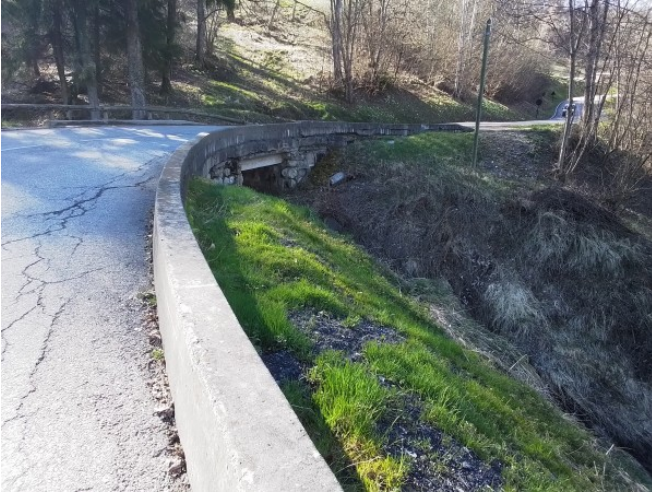
Figure III.10: Franchissement du Merderel sous la RD95.
