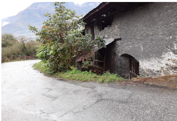
Figure III.22: Bâtiment exposé au ruissellement à l'angle du chemin en Carron et de la rue des Seigneurs-de-Cor.
