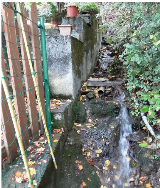
Figure III.17: Route de Bringer, passage du ruisseau de Grand-Cœur le long d'un muret.
