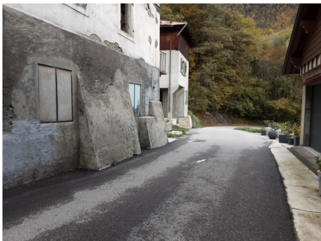
Figure III.28: Hameau Le Crozet, habitation avec contrefort.
