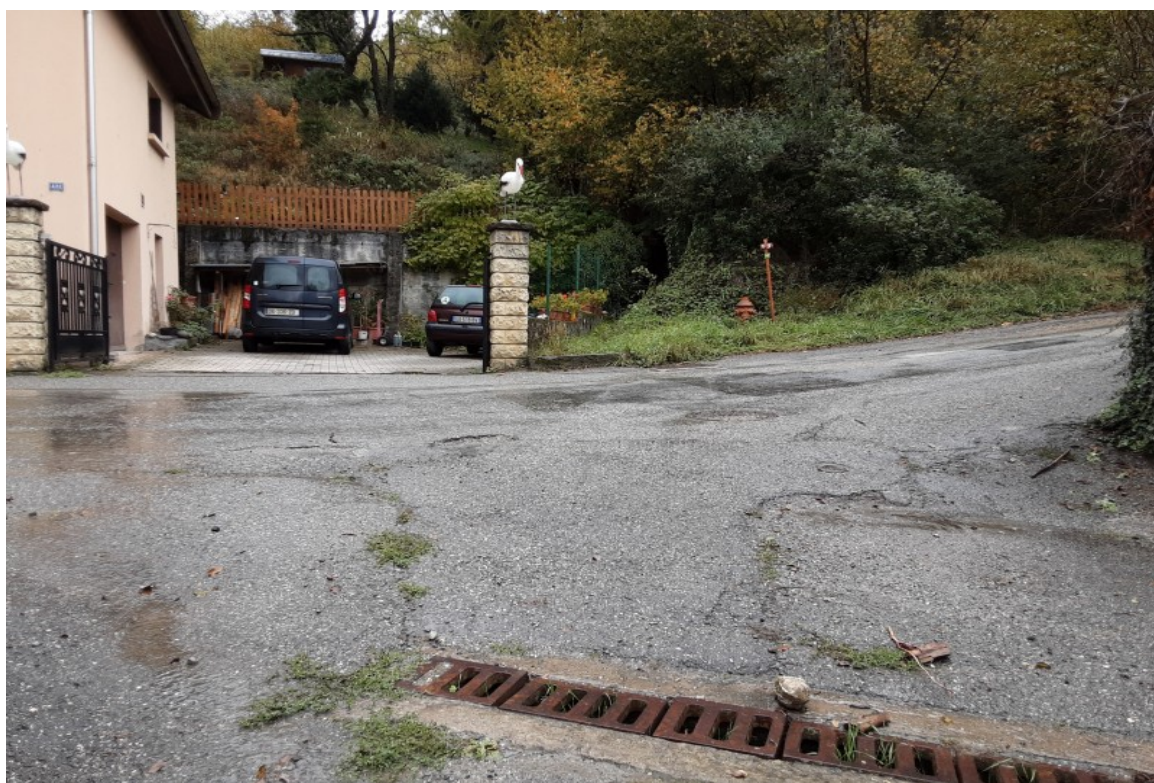
Figure III.19: Vue du ruisseau de Grand-Cœur bordant une propriété, de la route de Bringer et d'un avaloir en amont du chemin en Carron pour intercepter les eaux de ruissellements provenant du versant.
