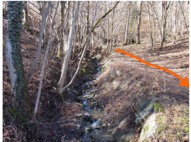
Figure IV.5: Vue de la levée de terre en rive gauche du Saint-Laurent (source : AGR, rapport PIZ 2018).
