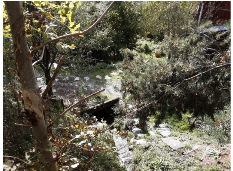
Figure III.13: Ruisseau de Navette, après busage sous le chemin de l'Oratoire, bref passage à l'air libre et de nouveau un passage couvert sous chemin d'accès.
