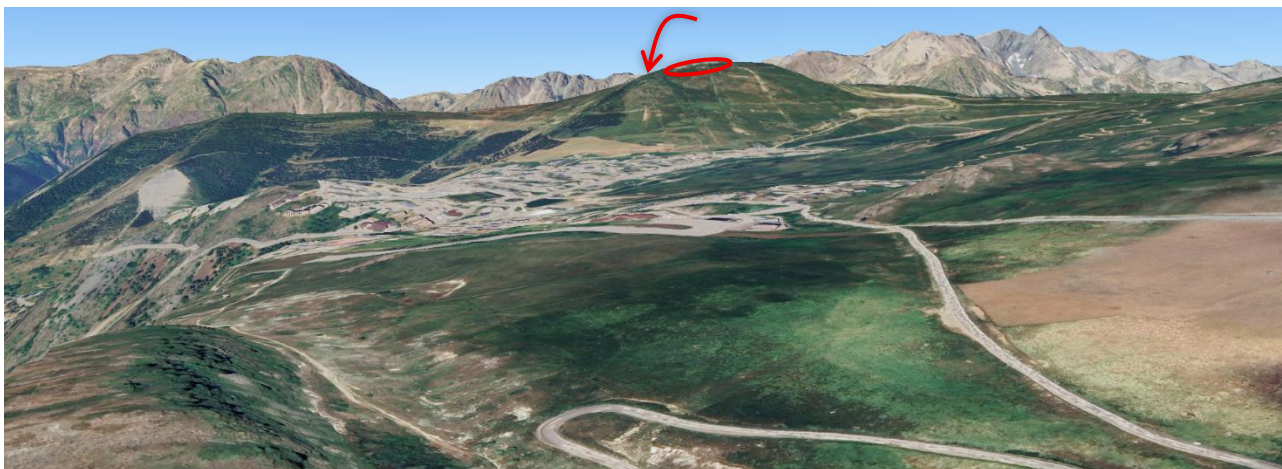
Vue modélisée de la zone d'étude depuis le site minier des Brandes. Source : Google Earth, annoté KARUM, 02/10/2025.
