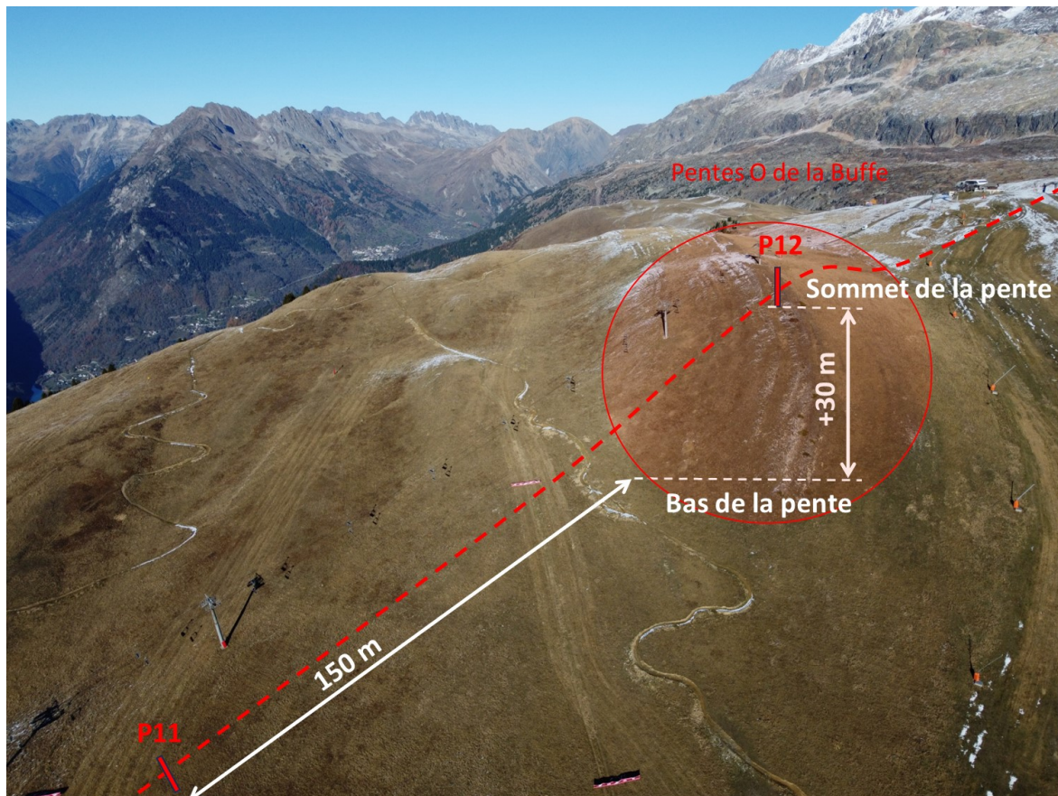
Photo 5 : 15/11/2024 – vue aérienne de la fin du tracé de la nouvelle télécabine du Villarais (pointillés rouges).
