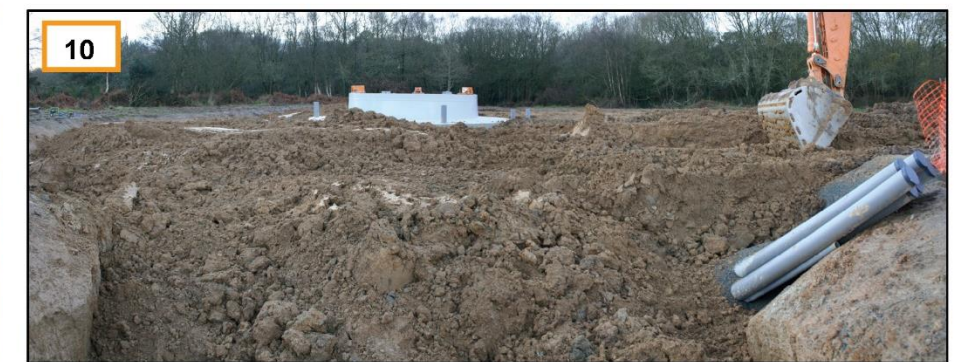
10 Remblaiement de la fondation de l'éolienne en cours
