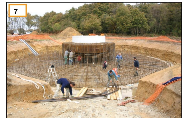
7 Ferrailage de la fondation de l'éolienne en cours
