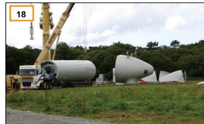
Livraison d'une section de mât
