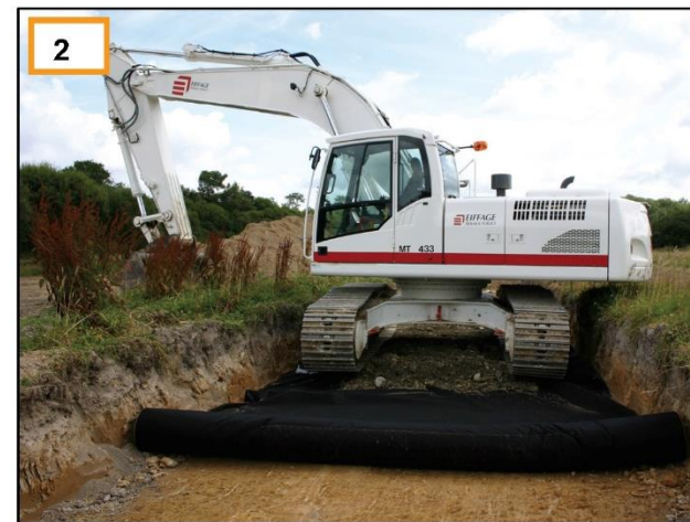
2 Mise en place du géotextile + empierrement
