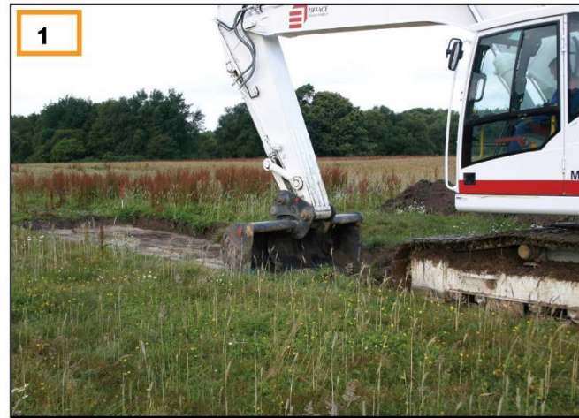
1 Début des travaux : chemins d'accès aux éoliennes
