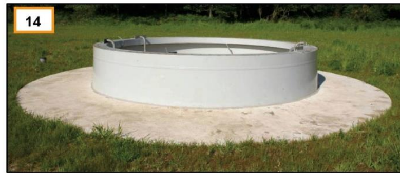
Fondation finalisée et prête à recevoir le mât
