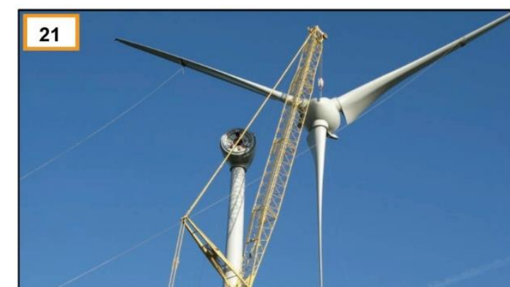
Assemblage du rotor sur la génératrice
