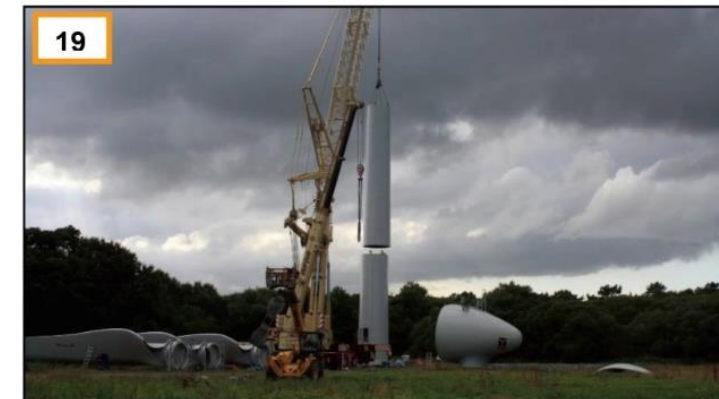
Assemblage d'une section de mât
