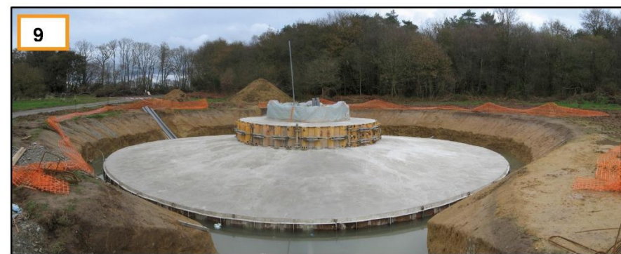
9 Coulage du béton de l'éolienne terminé
