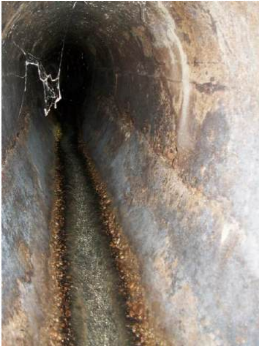
Collecteur rue de la Loire Avant et après sa réhabilitation
