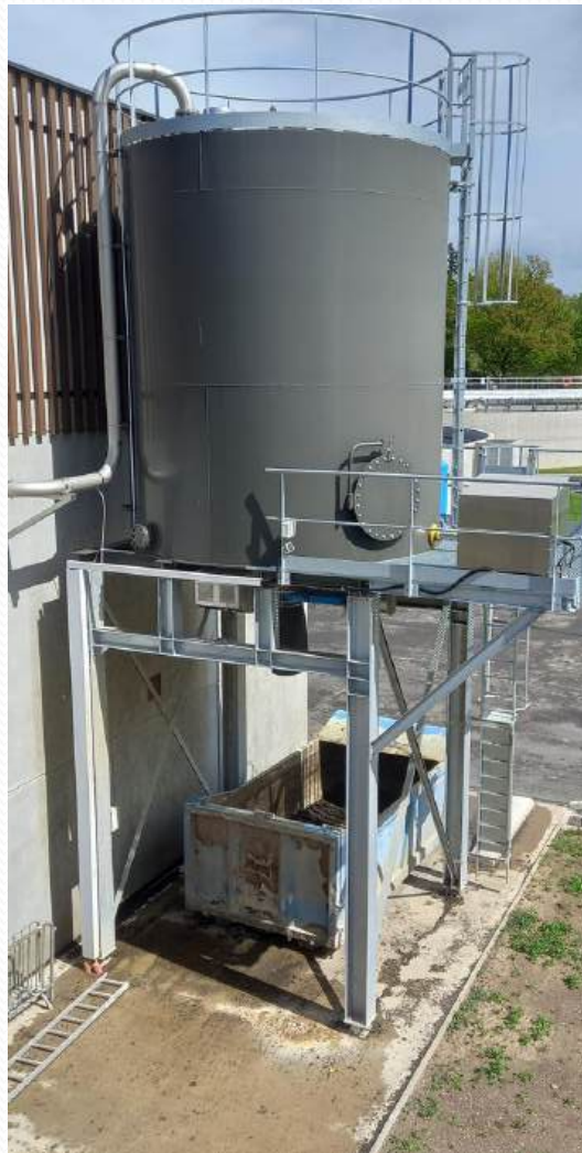
Silo à boues
