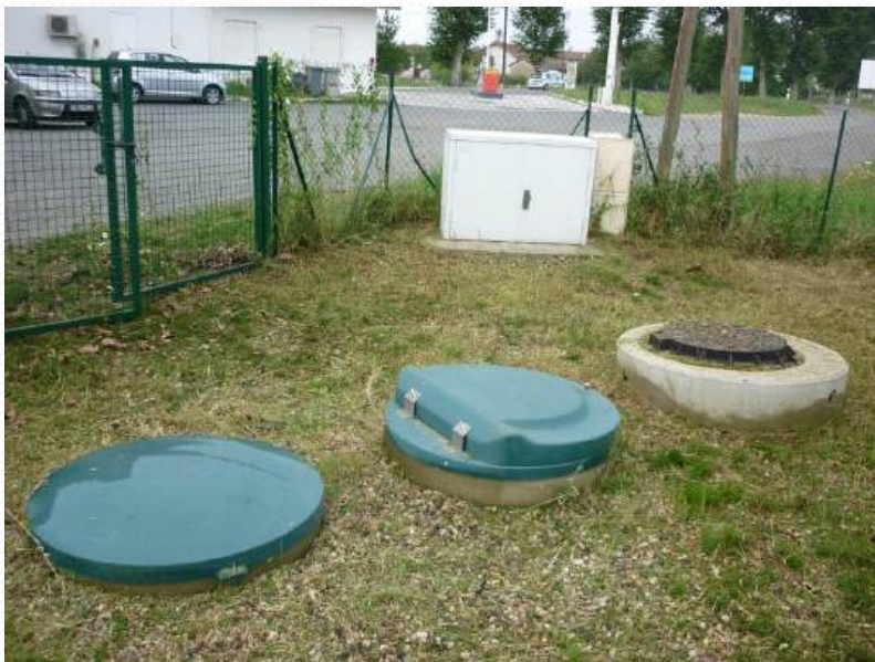
Poste de relevage de Bigny
