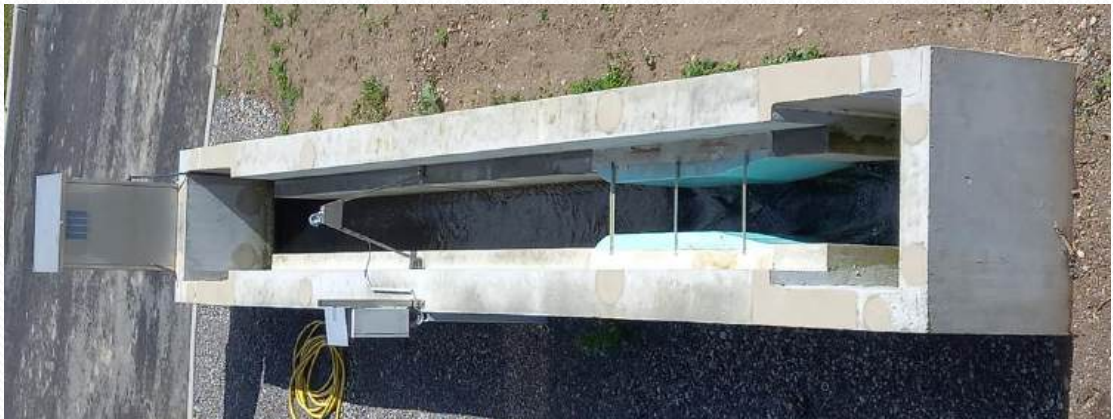
Canal de sortie
