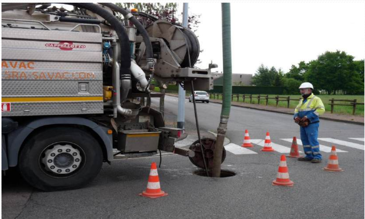
Camion de curage en intervention sur le réseau d'assainissement
