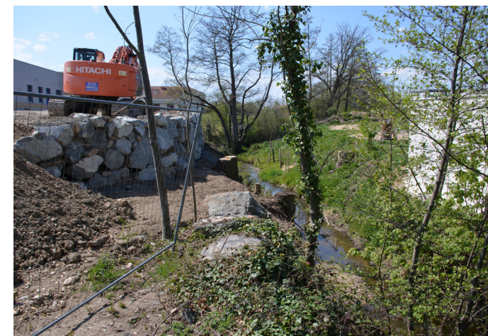
Coupure à l'urbanisation le long du ruisseau des Vauches (photo Luc Laurent)
