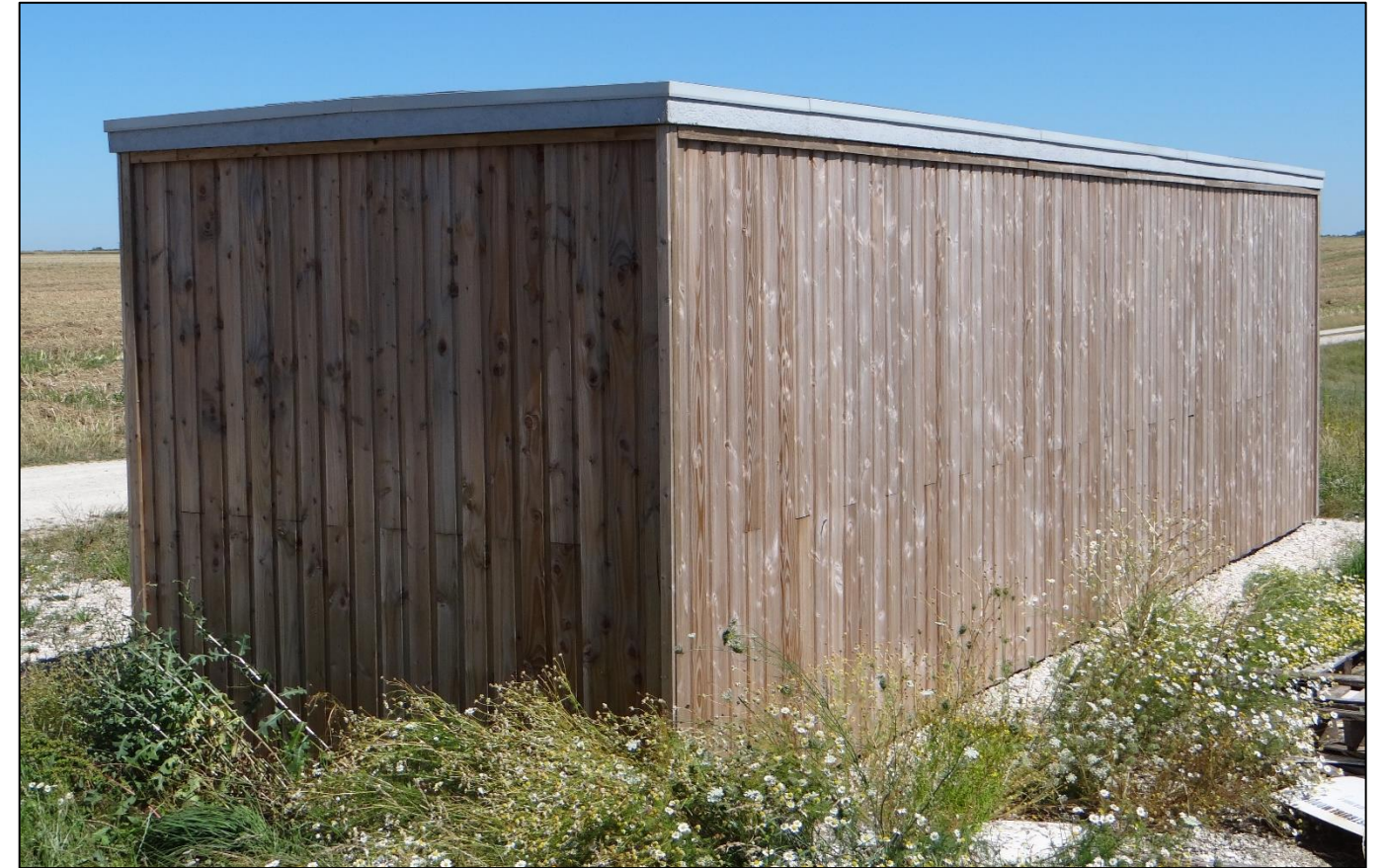
Photo 5 : Référence d'un bardage bois vertical pour un poste de livraison (Source : BE Jacquel et Chatillon)
