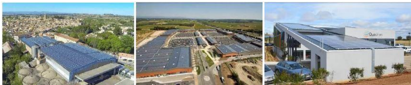
Photo 3 : Centrales photovoltaïques au sol (Source : TotalEnergies Renouvelables France)
