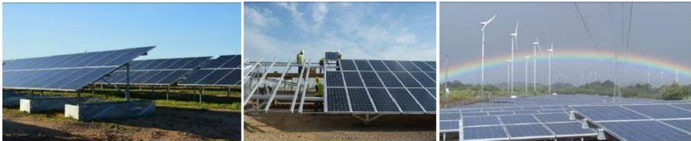
Photo 2 : Centrales photovoltaïques au sol (Source : TotalEnergies Renouvelables France)
