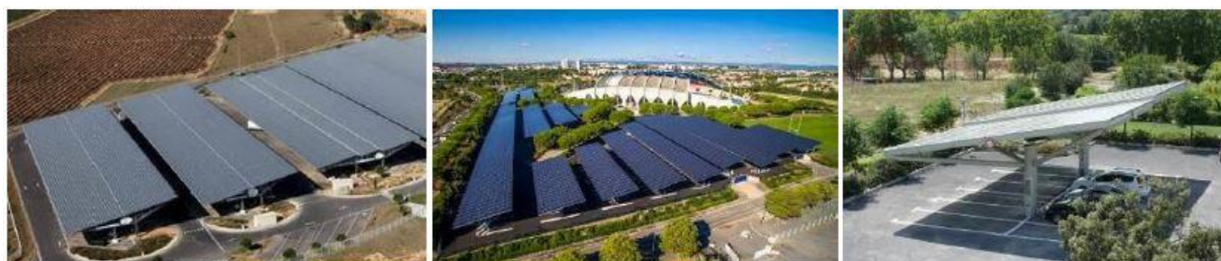
Photo 4 : Centrales photovoltaïques en toiture (Source : TotalEnergies Renouvelables France)
