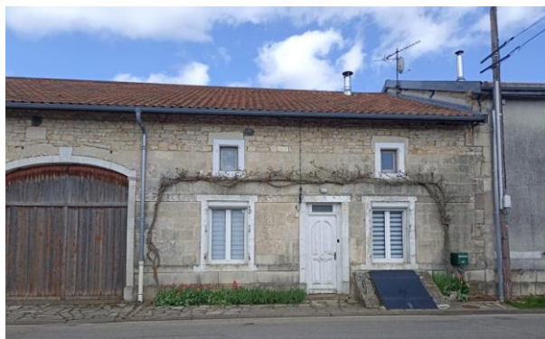
Cave dont l'accès est condamné à Mauvages, comme sur de nombreuses habitations du secteur.
