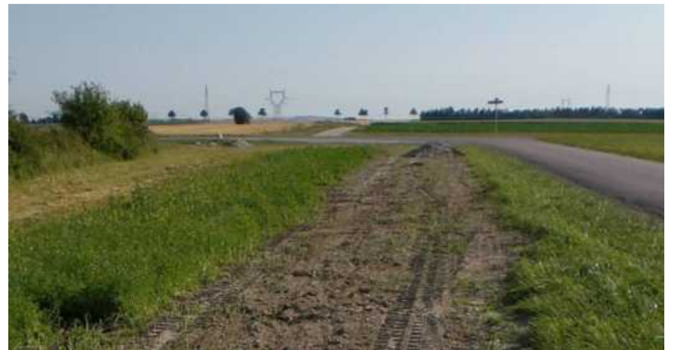
Photo 71 : Rebouchage de tranchée après passage des câbles électriques (Source : BE JC)
