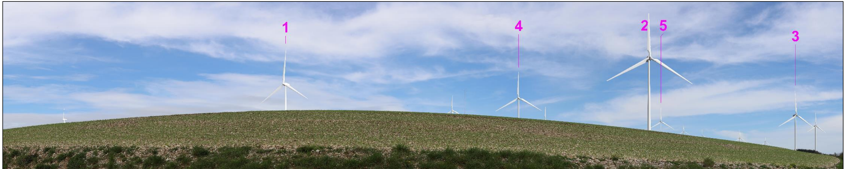
Photo 7 : Insertion du projet dans son environnement en vue proche, depuis la ferme La Grangette, à 688 m du projet, angle de 120° (Source : BE Jacquel et Chatillon)
