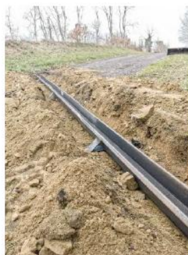
Exemple de mise en place de revets d'eau dans des chemins remblayés
