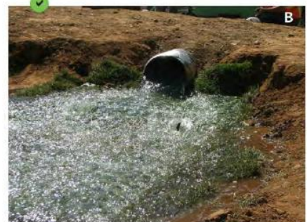
Exemple de buse sous une piste remblayée
