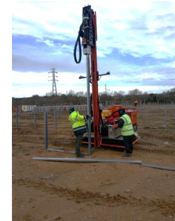
Battage des pieux
