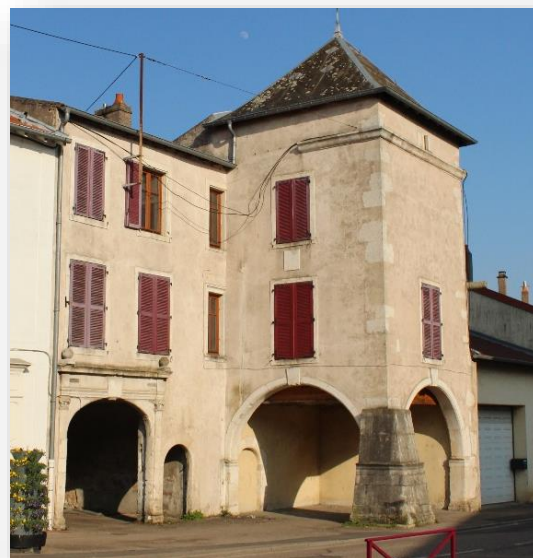
Maison des Prémontrés, photo ESTERR
