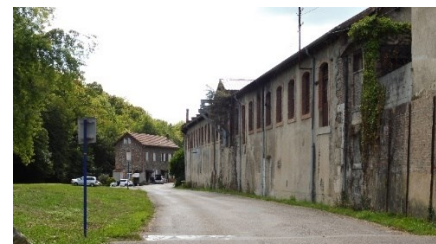
N°3- Bâtiment de l'ancienne usine de la Papeterie BFK de la Liampre en zone Nco Fiche n° 59145 de l'inventaire du patrimoine
