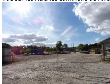
Les installations de la SACEP en zone UI
