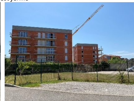
Réalisation Av Charles De Gaulle d'une opération d'habitat collectif de 75 logements, riveraine d'un quartier pavillonnaire
