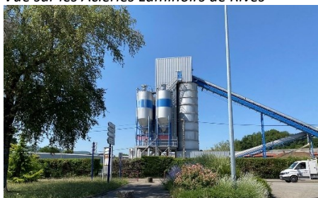
La centrale à béton – Zone UI du Levatel
