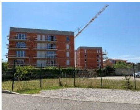
75 logements collectifs en cours, Rue du Vercors (secteur Gare) – JK Promotion
