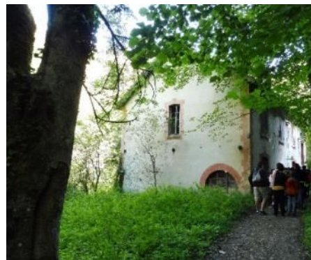
Centrale hydroélectrique de la Grande Poype toujours en activité
