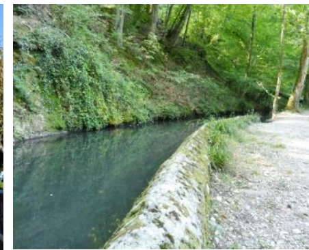
Canal d'amenée d'eau surplombant la Fure plusieurs mètres en contrebas
