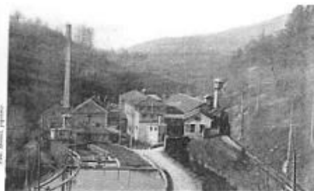
L'usine de la Liambre
