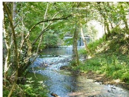
Chute d'eau de 7,3 m – La Fure
