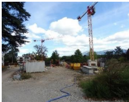
118 logements collectifs à la Moyroude – Rue de la Moyroude, Rue des Amours – COGECO Immobilier
