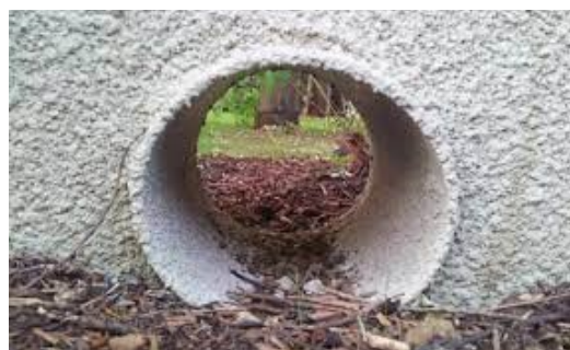
Aménagements d'ouvertures en pied de muret
