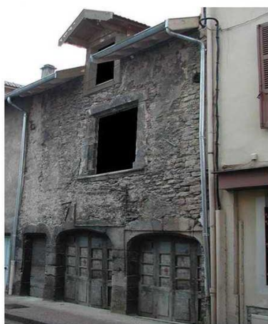
Etat de l'immeuble avant travaux
