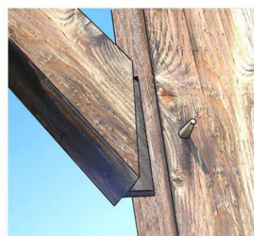
Assemblages "tenon / mortaise" (l'écartement d'un mur ou d'un poteau peut entraîner la rupture d'une cheville et le déboîtement d'un assemblage)
