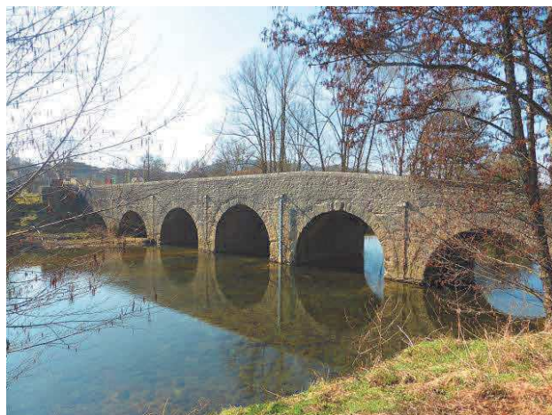
Rivière de l'Ouche et patrimoine associé
