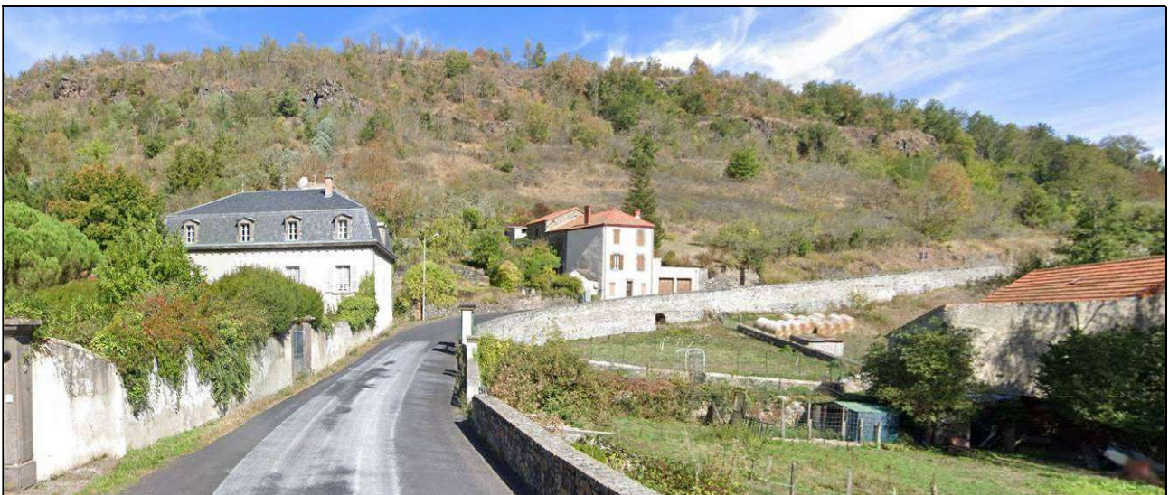
Vue Sud depuis la RD 23 à la sortie d'Ardes-sur-Couze sans covisibilité
