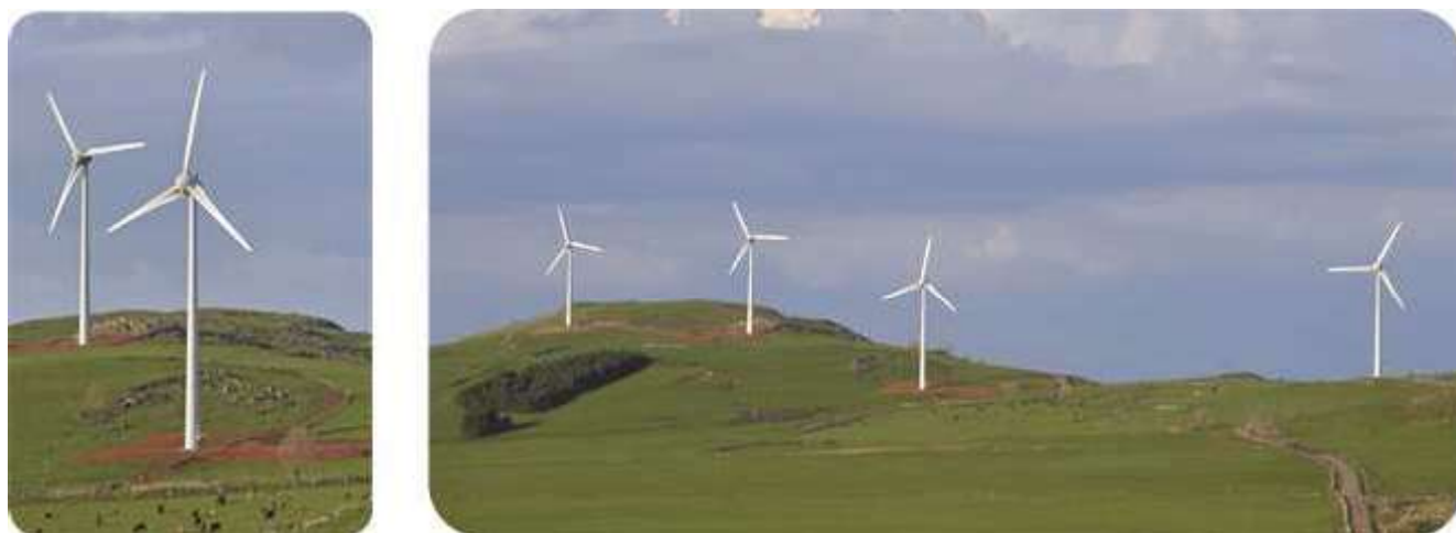
Champ éolien de « Saulzet » - Source Ardes-Communauté
