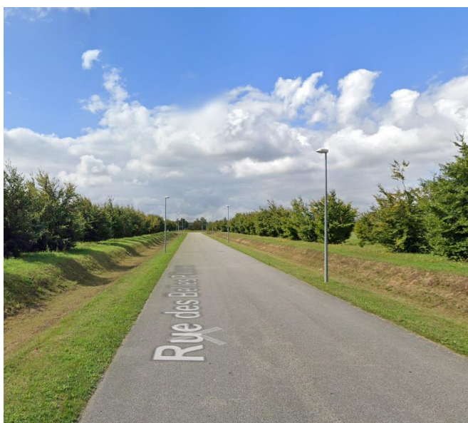
Figure 3-21 : Allée des Belles pâtures (avant travaux d'extension), vue en direction du château
