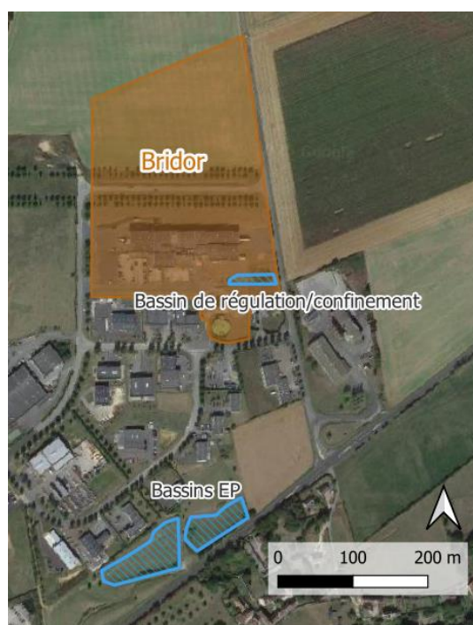
Figure 3-9 : Bassins de la zone Expansia
