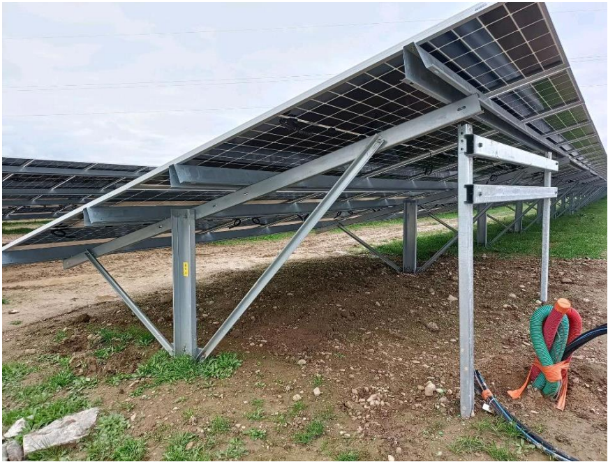
Exemple de système d’ancrage au sol
