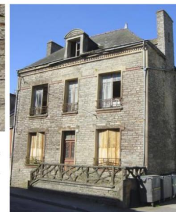
⑤ Maison de bourg en Plumelec Gros œuvre : murs en pierres de taille granitiques
