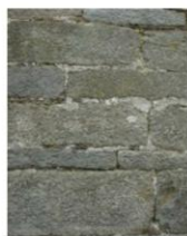
② Maison d'habitation en Boduic (Cléguérec) (18 ème siècle) Gros œuvre : murs et encadrements en pierres de taille de grès vert
