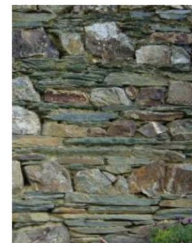
③ Musée de l'électricité en St-Aignan Gros œuvre : murs en pierres de schiste et grès ; encadrements en granite taillé
