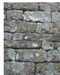
⑥ Maison de bourg en Guéhenno Gros œuvre : murs et encadrements en pierres de taille granitiques
