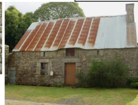
④ Bâtiment en St-Just (Bignan) Gros œuvre : murs en moellons granitiques ; encadrements en granite taillé
