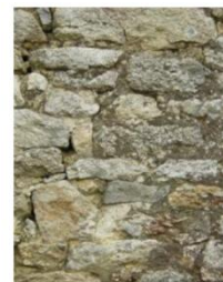
④ Bâtiment en St-Just (Bignan) Gros œuvre : murs en moellons granitiques ; encadrements en granite taillé
