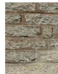
⑤ Maison de bourg en Plumelec Gros œuvre : murs en pierres de taille granitiques
