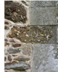
⑦ Chapelle St-Marc en Bréhan (17 ème siècle) Gros œuvre : murs en pierres de schiste, roussards et moellons gréseux ; encadrements en granite taillé ; chaînage en granite et roussards ; enduit encore visible sur les murs extérieurs
