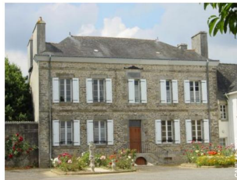
⑤ Presbytère en Moréac Gros œuvre : murs en pierres de schiste ou grès schisteux ; encadrements en granite taillé
