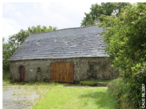
① Ancien bâtiment sur la route de Silfiac à Séglien Gros œuvre : murs en moellons granitiques ; encadrements en granite taillé ; couverture en larges pierres d'ardoise
