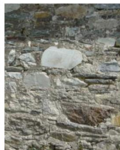
② Maison d'habitation en Malvran (St-Aignan) (19 ème siècle) Gros œuvre : murs en pierres de schiste et grès
