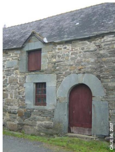
③ Ferme en Cléguérec (18 ème siècle) Gros œuvre : murs en pierres de schiste et moellons gréseux ; encadrements en grès vert
