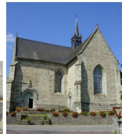
⑧ Chapelle Notre-Dame-de-Bonne-Encontre en Rohan (16 ème siècle) Gros œuvre : murs en pierres de schiste, pierres de taille de granite et de grès vert ; encadrements et chaînage en granite taillé ; piliers en pierres de taille granitiques avec quelques pierres calcaires à la base
