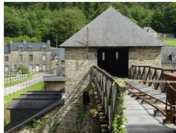
① Anciennes Forges des Salles en Ste-Brigitte (19 ème siècle) Gros œuvre : murs en pierres de schiste ; encadrements en granite taillé
