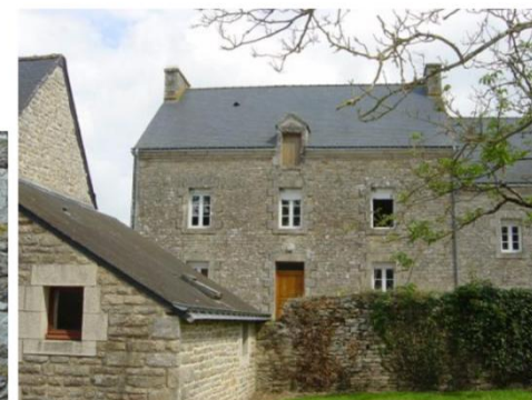
⑥ Maison de bourg en Guéhenno Gros œuvre : murs et encadrements en pierres de taille granitiques
