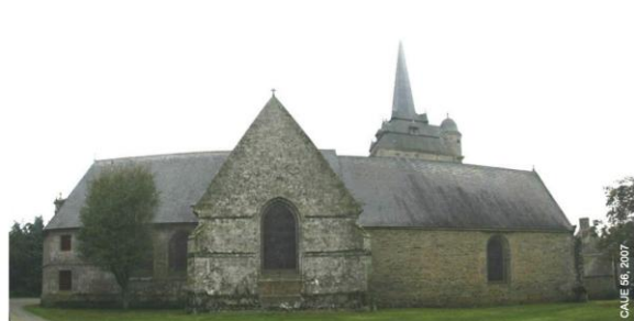
① Chapelle Notre-Dame-de-Carmes en Neulliac Classement aux Monuments Historiques (15 ème siècle) Gros œuvre : murs en pierres de taille granitiques et pierres de schiste, encadrements et chaînage en granite taillé ; alternance régulière de granite et de schiste sur certains pans de mur
