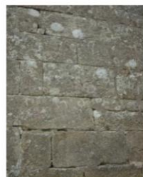
② Logis en Kergohan (Séglien) (17 ème siècle) Gros œuvre : murs et encadrements en pierres de taille granitiques
