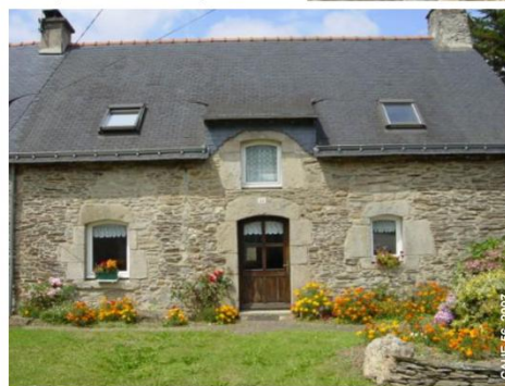
⑥ Maison de bourg en Radenac Gros œuvre : murs en pierres de schiste ; encadrements en granite taillé
