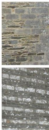
① Chapelle Notre-Dame-de-Carmes en Neulliac Classement aux Monuments Historiques (15 ème siècle) Gros œuvre : murs en pierres de taille granitiques et pierres de schiste, encadrements et chaînage en granite taillé ; alternance régulière de granite et de schiste sur certains pans de mur
