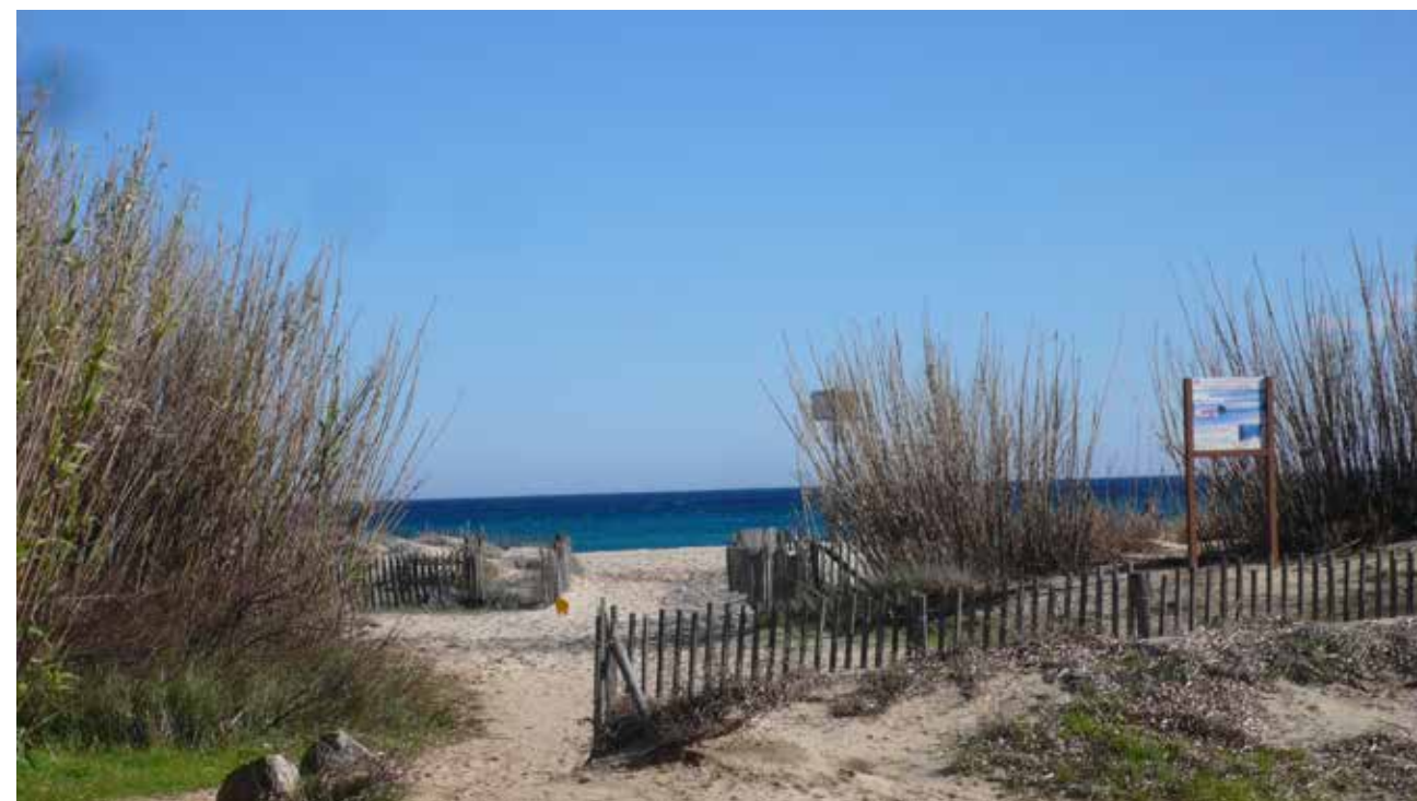
Fig 68 : Un réseau de cheminements piétons marqué par des ganivelles dans la dune, au niveau du secteur de Bonne Terrasse.
