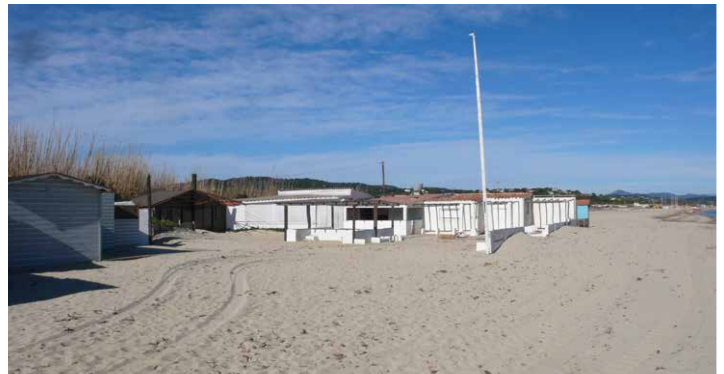
Fig 24 : L'arrière des établissements de plage se caractérise souvent par un cumul de structures disparates.
