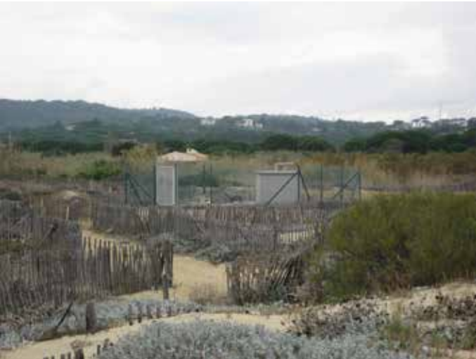
Fig 102 : Station de refoulement de Salagrue dans la zone protégée du cordon dunaire
