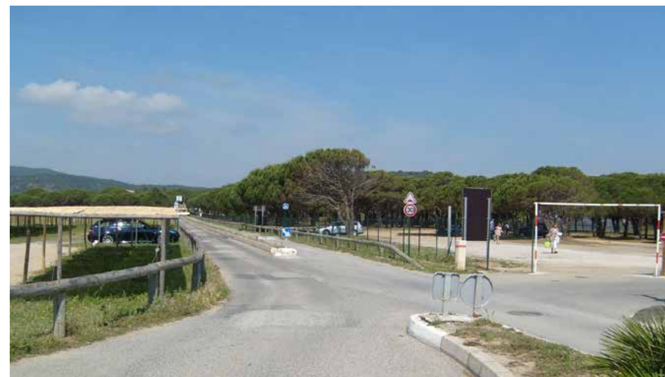
Fig 70 : La route de l'Epi : un système de protection des piétons et de limitation du stationnement sauvage en ronds de bois. Cette voie dessert deux aires de stationnement privées.
