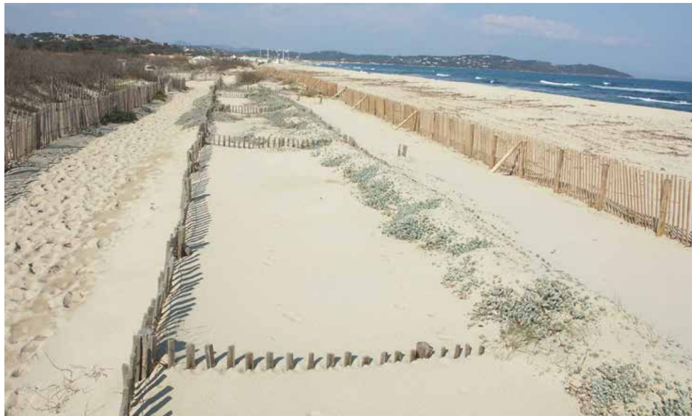
Fig 35 : Régénération du bombement dunaire par implantation de ganivelles et plantation de diotis
