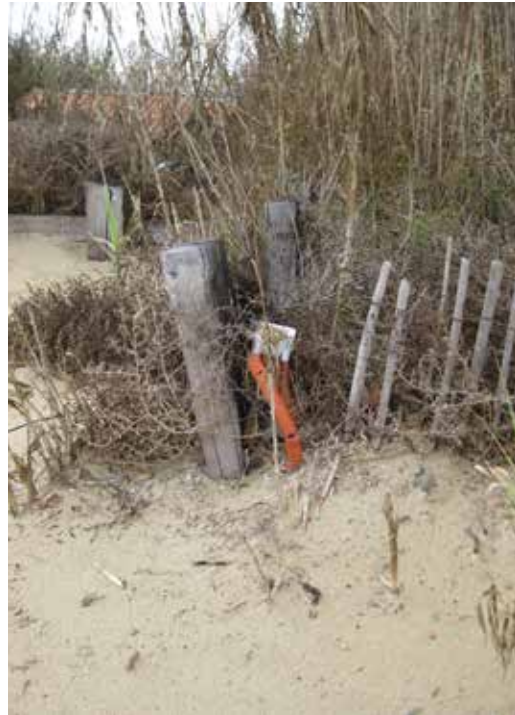
Fig 118 : Raccordement électrique privé (connexions non étanches – accessibles par tous)
