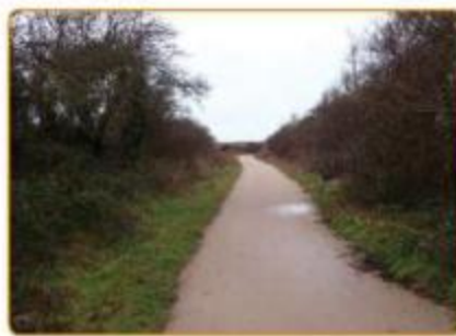
Milieu dunaire en Vendée : revêtement en sable compacté sans liant, qui se révèle résistant dans la durée bien roulant, compact, et à faible entretien (espace remarquable du littoral, site classé et Natura 2000 ).
