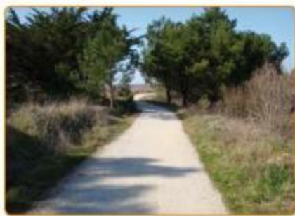
Voie cyclable littorale dans le massif dunaire de Gâvres-Quiberon : stabilisé sable renforcé avec un liant minéral (espace remarquable du littoral, site classé et site Natura 2000 ).
