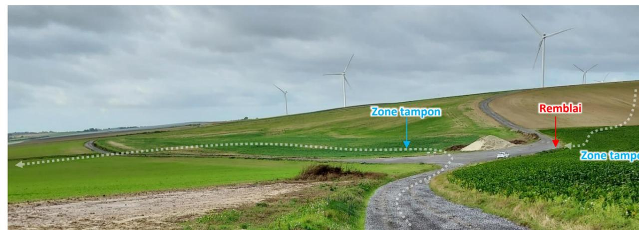
Photo 2 (vues a/b) : Dys01 et Dys01bis – Discontinuité hydraulique et érosion du chemin
