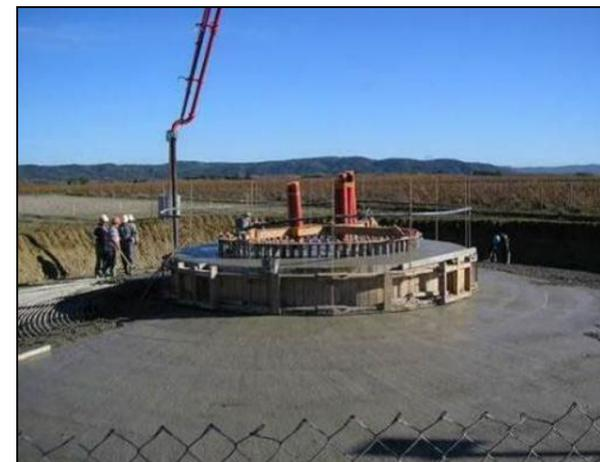
Photo 13 : Coulage du béton
