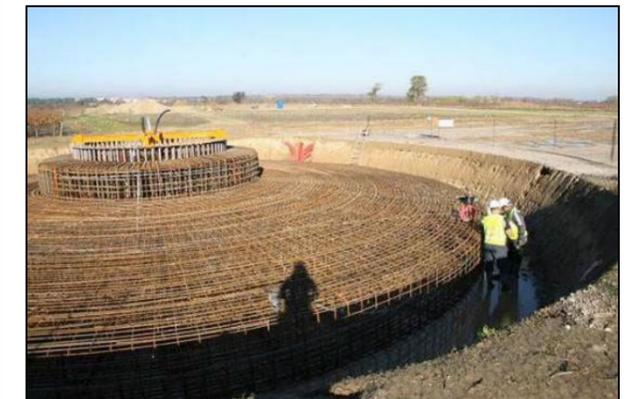
Photo 12 : Ferrailage de la fondation
