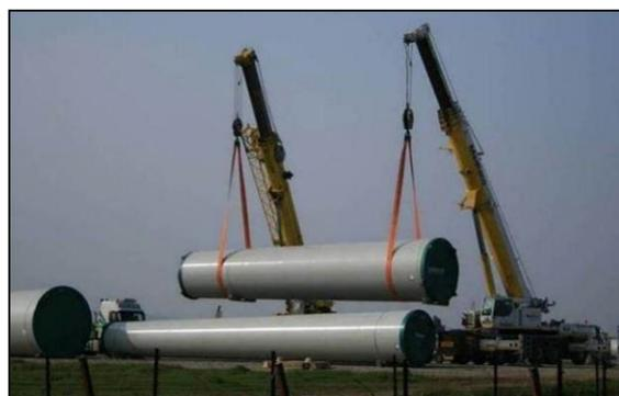
Photo 16 : Manipulation des tronçons d'éoliennes
