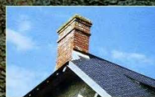
Souche de cheminée en brique
