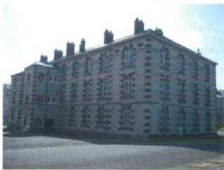
FACADES SUD ET EST
