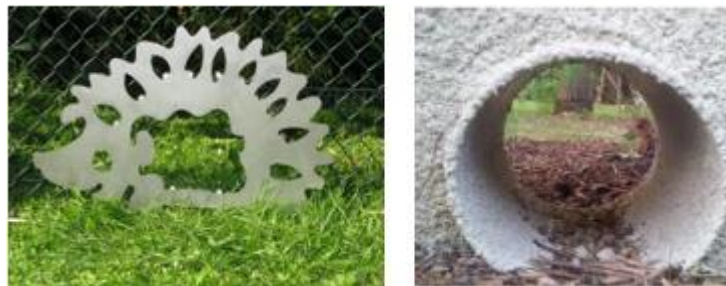
EXEMPLES D'OUVERTURES DANS UN GRILLAGE ET UN MURET, PREVUS POUR LE PASSAGE DE LA PETITE FAUNE (SOURCE : U2B - LIMITER L'IMPACT DES CLOTURES SUR LA BIODIVERSITE, 2014)
