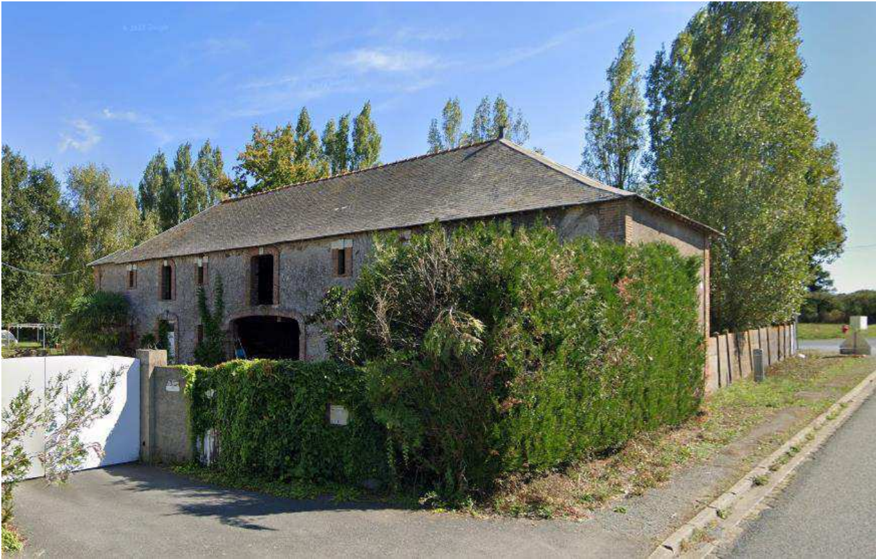
Dépendance maison de la Gare
