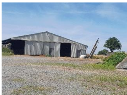
Trémentines – Bâtiment d'élevage
