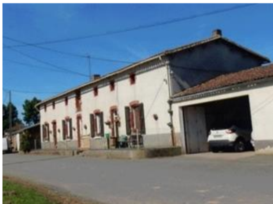
Corps de ferme à Yzernay
