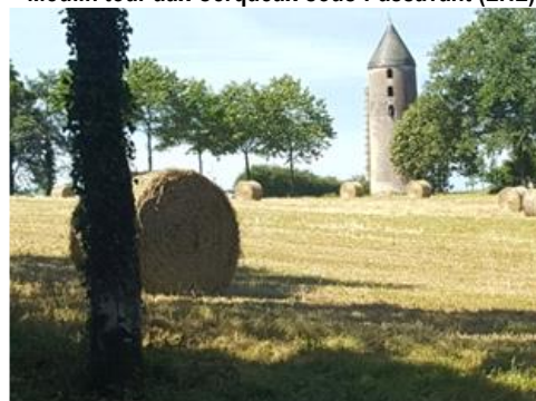
Moulin tour des Landes à Bégrolles-en-Mauges
